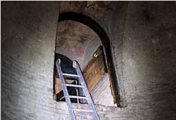
De enige toegang tot de bodem van de kelder.
