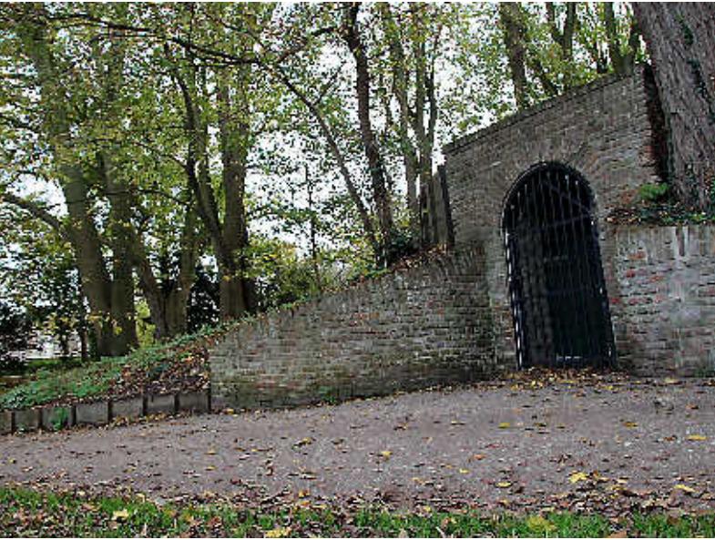
De toegang tot de ijskelder op het Clarissenbolwerk. De deur achter de tralies heeft een speciale gleuf om vlemuizen binnen te laten.
